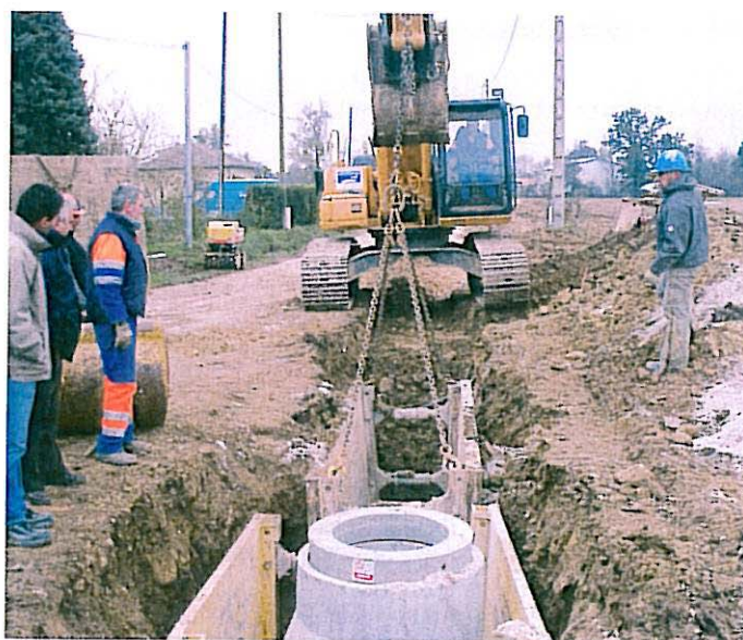
Début des travaux du réseau de collecte
