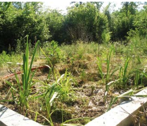
Un bassin filtre planté à Biolande, gîte rural écologique situé en Charente (voir Habitat Naturel n°4).
